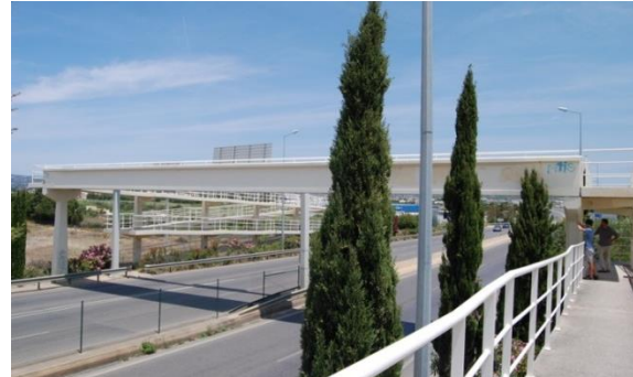
d) Vista geral da viga SO
