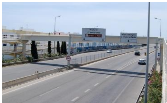
c) Vista geral do alçado NE
