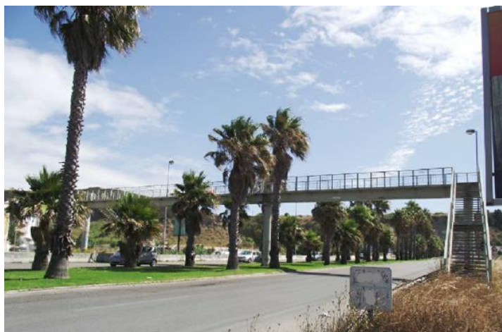
Figura 1. Vista lateral da ponte pedonal
