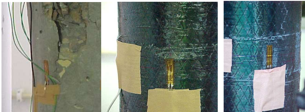
Figura 4.10: Extensómetros verticais colocados nos modelos de betão e com CFRP
