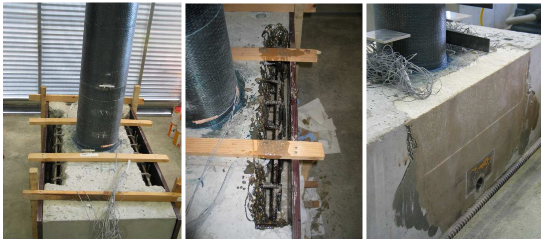
Figura 7.5: Pormenores da sapata do pilar P10 antes, durante a betonagem e após o reforço
