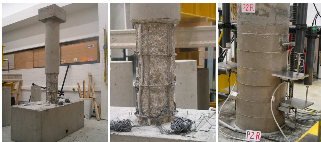
Figura 7.2: Pormenores do pilar P2R antes e após o reforço
