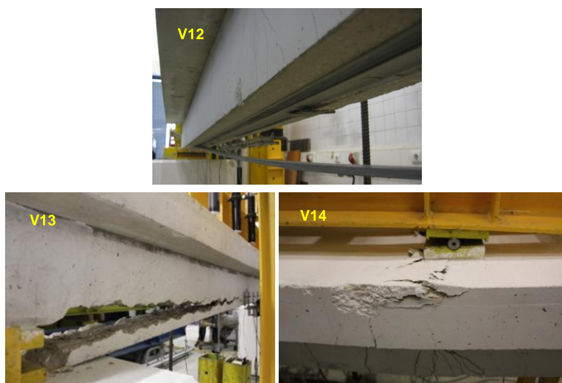
Figura 7 – Modos de rotura observados nos ensaios das vigas V12, V13 e V14.
