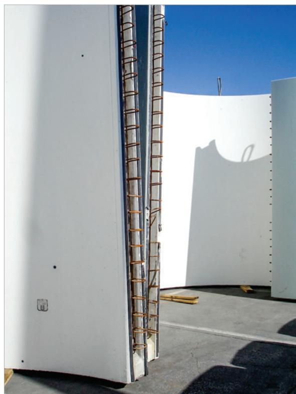
Figura 22 – Anéis semicirculares pré-moldados em concreto na base da torre, com juntas verticais e horizontais
