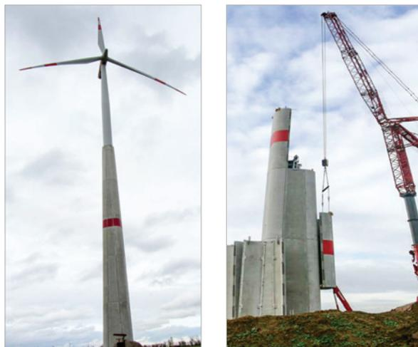
Figura 24 – Solução ATS - torre híbrida em concreto pré-moldado e aço (à esquerda) e montagem (à direita) [10, 11]
