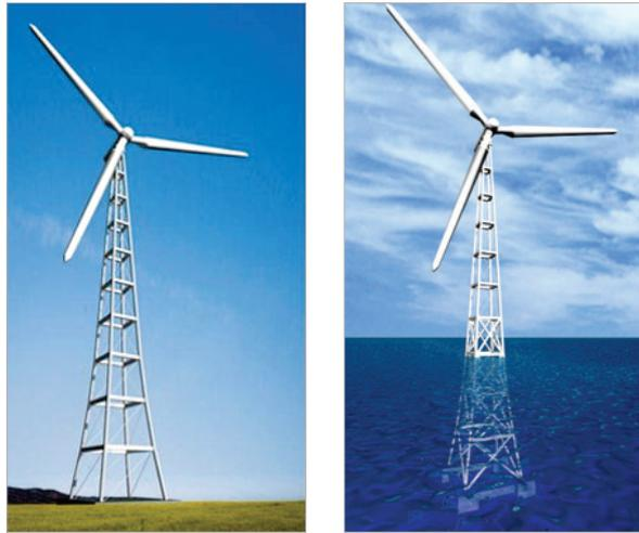
Figura 18 – Torre treliçada pré-moldada em concreto armado desenvolvida pelos autores para *onshore* (à esquerda) e *offshore* (à direita)
