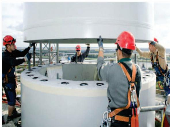
Figura 21 – Ligações horizontais entre dois anéis pré-moldados de concreto (fonte: Enercon)
