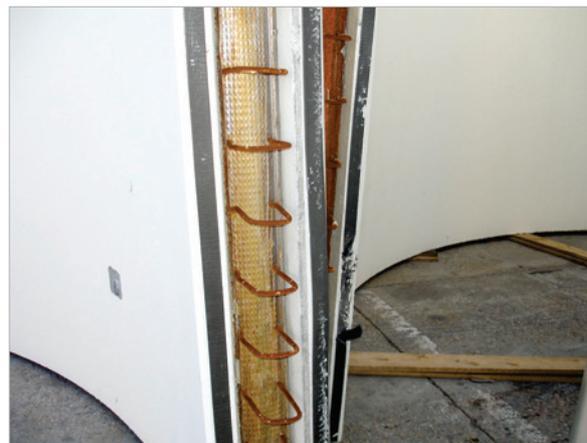
Figura 23 – Detalhe de uma junta vertical
