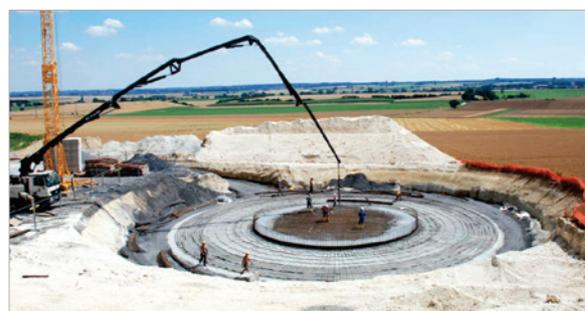
Figura 12 – Fundações (*onshore*) de grandes dimensões sobre as quais será colocado a torre tubular para suportar o aerogerador
