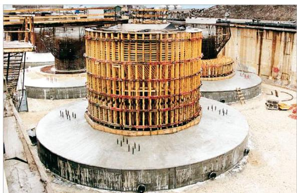
Figura 14 – Fundação de gravidade em concreto pré-moldado para águas pouco profundas. A torre é montada no topo [05]
