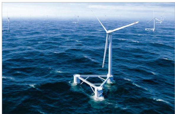
Figura 13 – Fundações flutuante da EDP a utilizar em águas profundas
