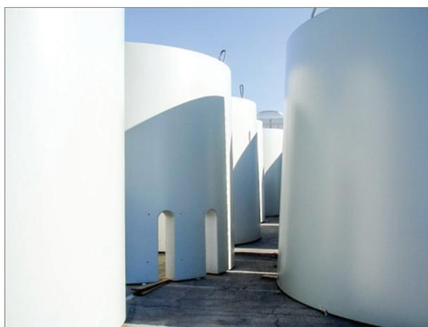
Figura 17 – Torre em concreto pré-moldado para suporte de um aerogerador (à esquerda) (Wikimedia commons); Anéis pré-moldados típicos deste tipo de estrutura (à direita, fonte: ENERCON)
