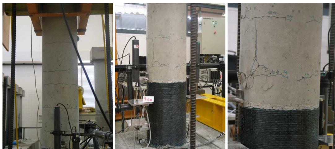
Figura 6.5: Pormenores da fendilhação observada no pilar P4
