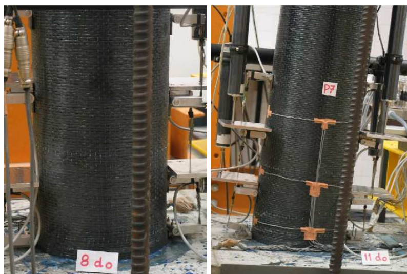
Figura 6.8: Pormenores da fendilhação observada no pilar P7
