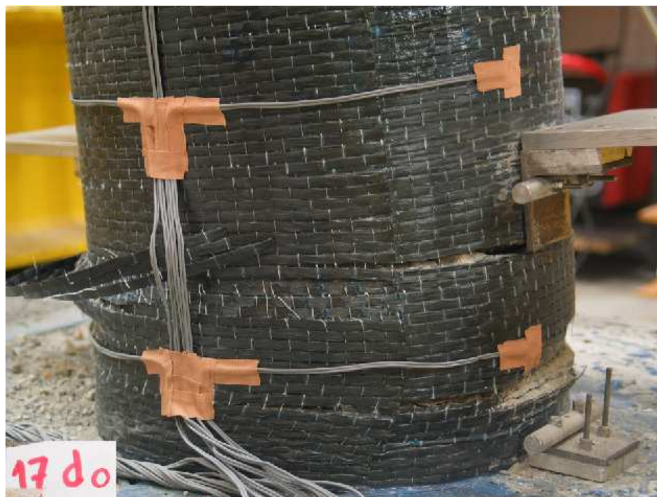
Figura 8.11: Pormenor da degradação do colete e das fendas, observado junto à base do pilar P7 no final do ensaio
