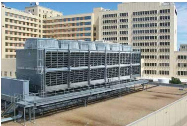
Figura 4: Condensador evaporativo localizado no exterior das instalações
