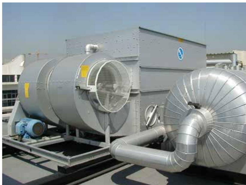
Figura 3: Condensador evaporativo
